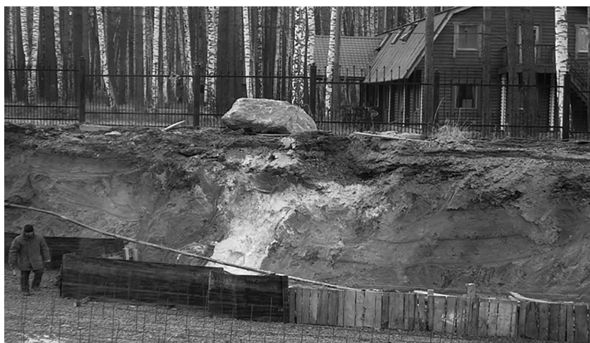
Белая глыба в котловане под фундамент храма в «сосуде» из плотной глины
